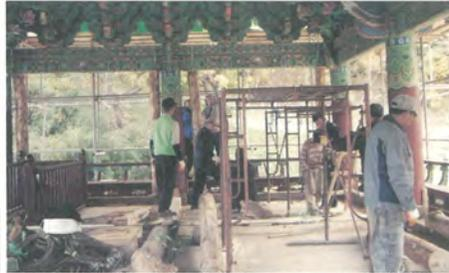
이층에 보호목 설치 및 장틀 보조 목들 설치
