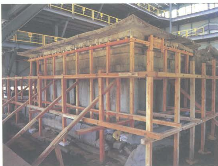
석탑 1층 해체 전 비계 설치 모습
