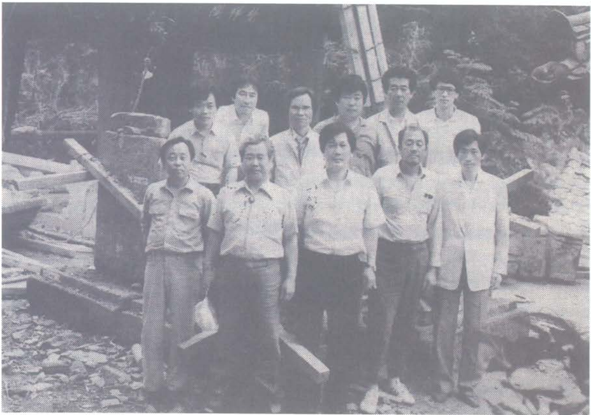
강진 금곡사 삼층석탑 해체수리 중 전면 우에서 두 번째가 고 홍정수 드잡이 장인이다.(금곡사 삼층석탑 수리보고서 인용)
